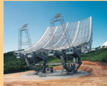
惑星プラズマ・大気研究センターでは福島県飯館村に惑星圏飯館観測所を開設し、2001年10月にパラボラアンテナ型惑星シンクロトン電波望遠鏡を完成(幅33m・高さ31m)。6億km離れた木星からの電波観測を行っています。(MAP②)
