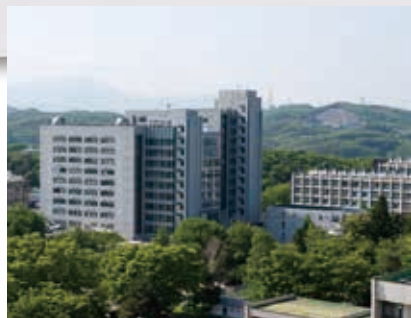
極低温科学センター棟別館 超伝導核磁気共鳴装置棟
