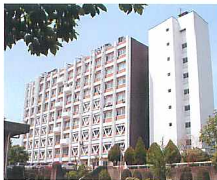
▲改修後の化学棟
