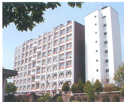
▲改修後の化学棟
