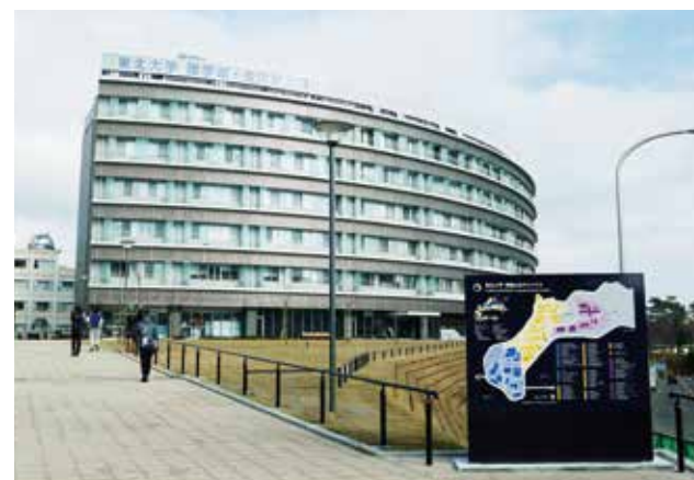
○青葉山駅北1出口を出てすぐ理学研究科。合同C棟南側には歩行者通路も整備され、通勤・通学がより便利になりました。
