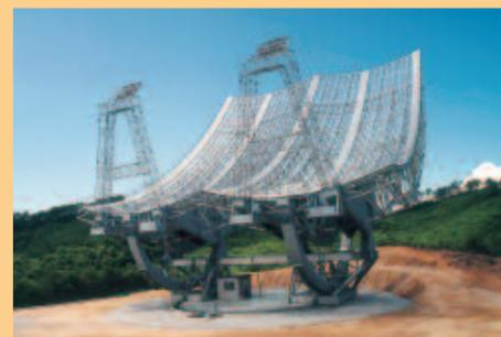
惑星プラズマ・大気研究センターでは福島県飯館村に惑星圏飯館観測所を開設し、2001年10月にパラボラアンテナ型惑星シンクロトロン電波望遠鏡を完成 (幅33m・高さ31m)。6億km離れた木星からの電波観測を行っています。(MAP②)
